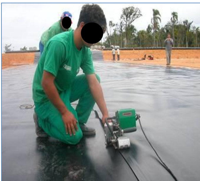
Figura 18: Ilustração da solda por termofusão de geomembrana de PEAD.
