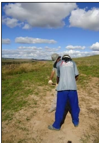
Figura 40: Realização de sondagem a trado.
