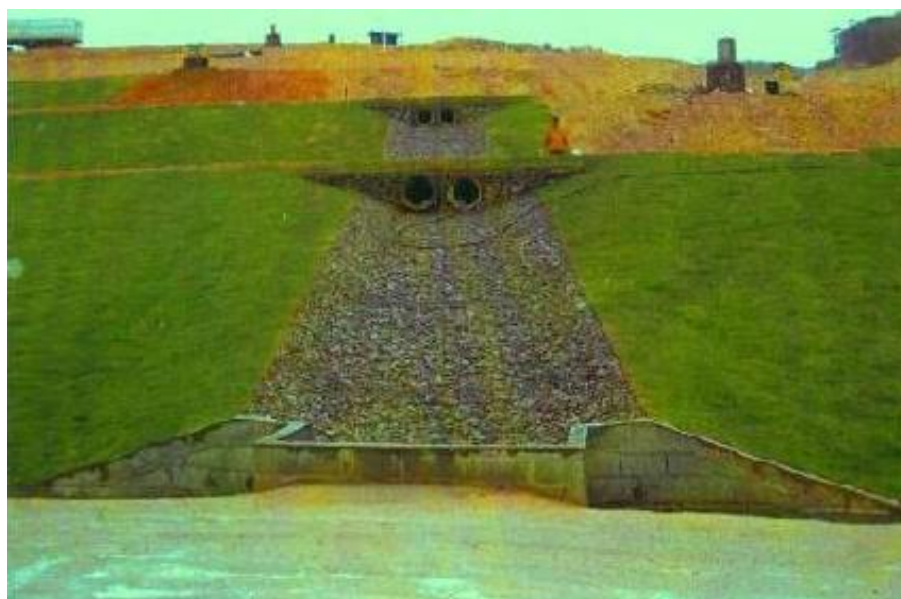
Figura 26: Exemplo de descida hidráulica em colchão Reno.
