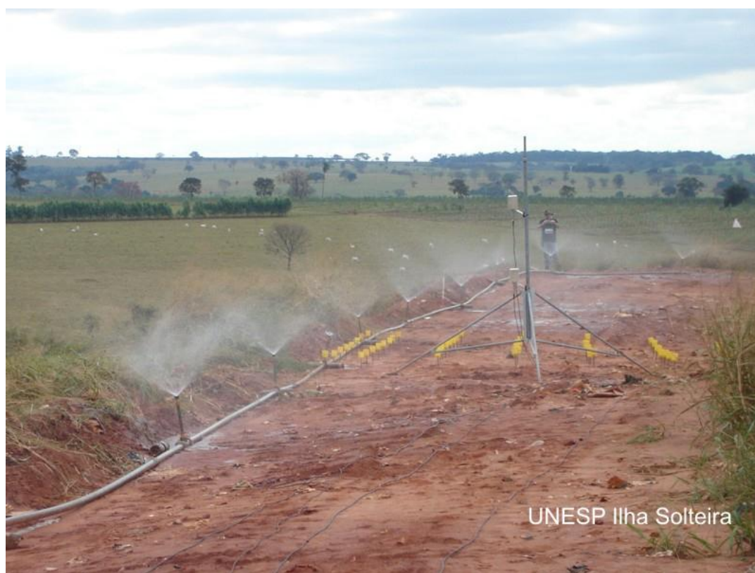
Figura 30: Aspersão de chorume sobre célula recoberta.
